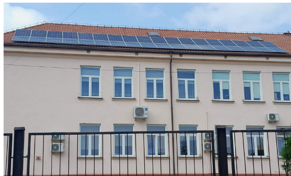
Z sukcesem zakończono kolejny projekt budowy instalacji fotowoltaicznych
