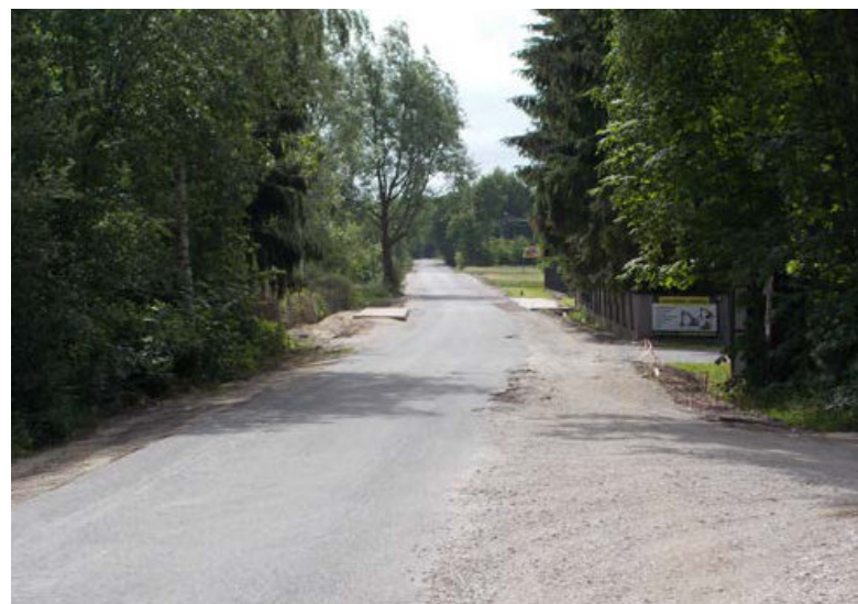
Droga Szczytno - Ługowiska
