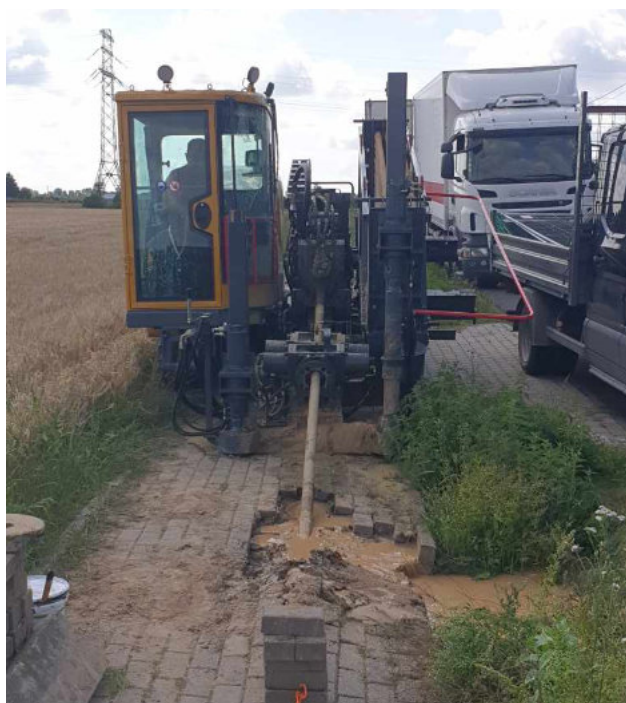
Wymiana rur cementowo-azbestowych w Śmiłowicach Szatkach i Skibicach
