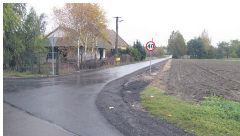
Przebudowa drogi w miejscowości Strzyżki-Mstowo
